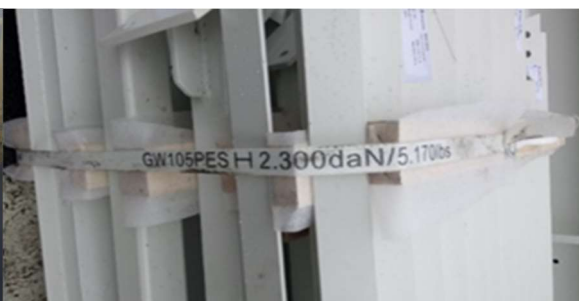
Poprawne znakowanie - zawieszka metalowa – oznaczenie elementu na palecie lub w paczce oraz przygotowanie belek do położenia konstrukcji na naczepie
